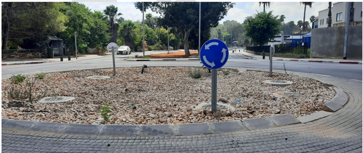
איור 65 | כיכר מחלחלת בפרדס חנה (טרם שתילת הצמחייה). תכנון הידרולוגי וצילום: אורי מורן
