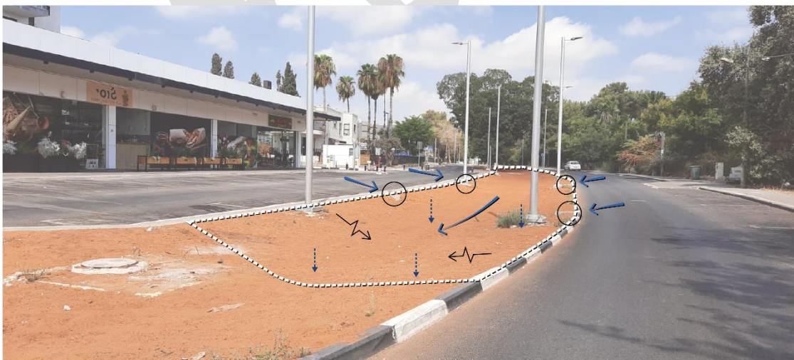
איור 29 | תעלת חלחול לפני שתילת צמחיה, רחוב הגלעד בפרדס חנה. תכנון הידרולוגי וצילום: אורי מורן
