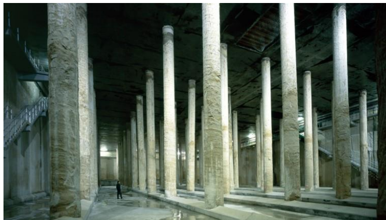
איור 55 / מאגר תת-קרקעי לויסות נגר מתחת לפארק Joan Miró בנפח של 54,000 מ"ק, ברצלונה, ספרד
