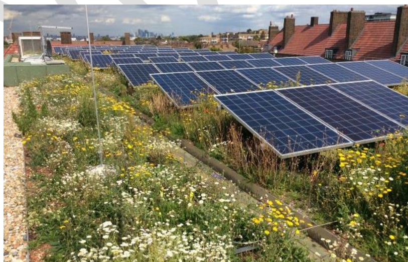
איור 51 / גג ירוק בשילוב תאים פוטו-וולטאים, בנין חברת Bauder, לונדון, אנגליה
