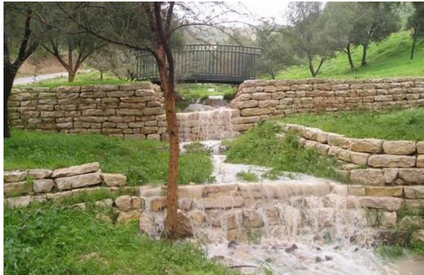
איור 26 / טרסות בסמוך למעלה אדומים - קק"ל
